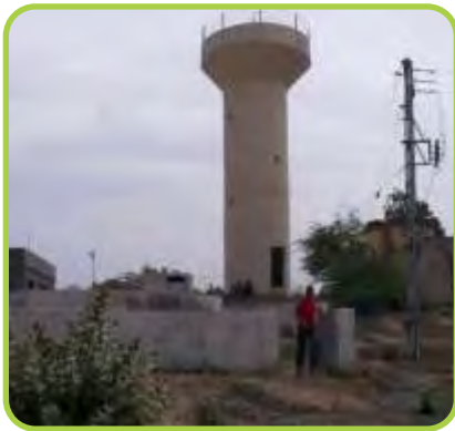
Overhead tank, Tappar
